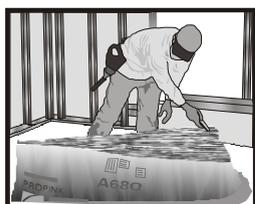
3.- Antes de abrir los paquetes colóquelos en el cuarto donde serán instalados. La manera de abrir el paquete es: cortando a lo largo con una navaja. El aislamiento viene comprimido, por lo que al abrirlo se expande, cuide que tenga suficiente espacio.
